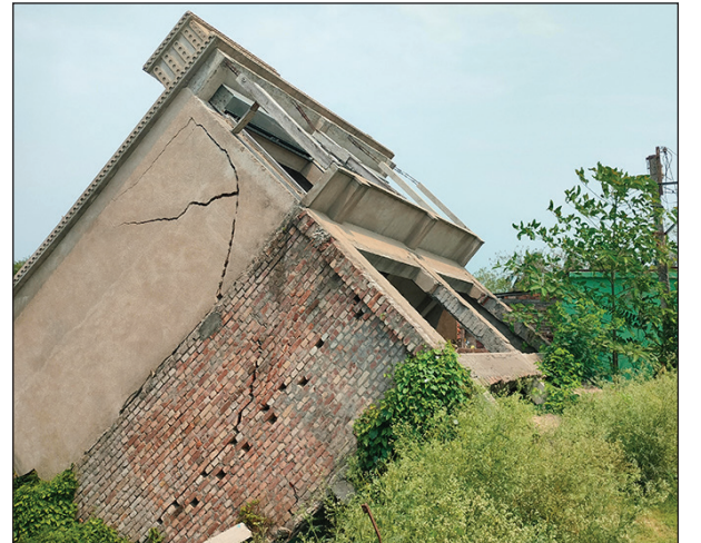
গোড়াই গলদ: গাদিয়ারা বাওয়ার রাস্তার এক পাশে, উলটে পড়ে আছে আসতো দোতলা বাড়ি। দেওয়ালেও ধরেছে কালি, আজকের দিনে শহর হোক বা গ্রাম, অসামু নির্মাণ কাজ বেড়েছে, চোখে পড়ার মতো। ছবি : অভিজিৎ কর
