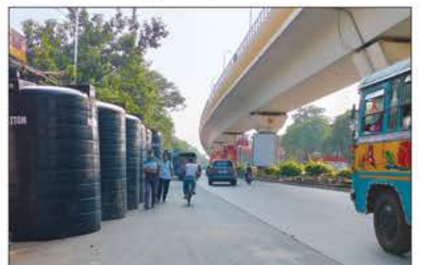
১০,০০০ লিটার এর জলের ট্যাঙ্ক এ ভরিয়ে ডায়মন্ড হারবার রোড, মেট্রো লাইনের লোড টেস্টের জন্য আনা হয়েছে এতো পরিমাণ ট্যাঙ্ক। সাথে শুরু হলো মেট্রোর ট্রায়াল রানও।
