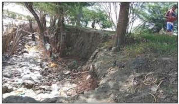
তৈরি। এমনকি পাইলনেও দেওয়া ছিল নদীর সাইড এরিয়ায়। কিন্তু নদীর জোয়ারের জলের তোড়ে সেই পাইলনের মাটি সরে গিয়ে শনিবার রাতে ধস নেমেছে রাস্তাতে। অন্যদিকে, ফ্রেজারগঞ্জ অঞ্চল তৃণমূল কংগ্রেসের সাধারণ সম্পাদক প্রসেনজিৎ জানা বলেন, প্রবল জোয়ারের দাপটে এটি হটাৎ করে ভেঙে গিয়েছে। ইরিশেশন ডিপার্টমেন্ট থেকে প্রথমে পাইলন দেওয়া হয়েছিল। পরে
