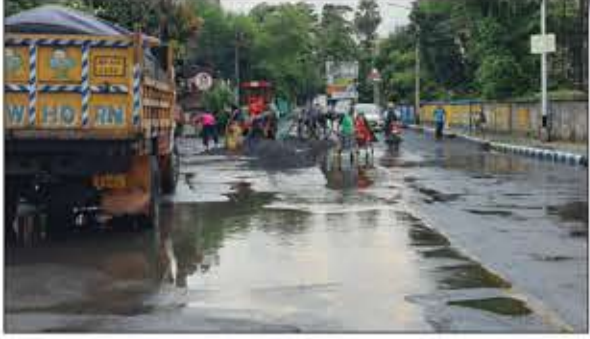
হচ্ছে বৃষ্টি, জমছে জল, সাথে চলছে জোর কদমে রাস্তা মেরামত এর কাজও। কিন্তু তার ডবলঘা কতদিন তা কেউ জানে না।
