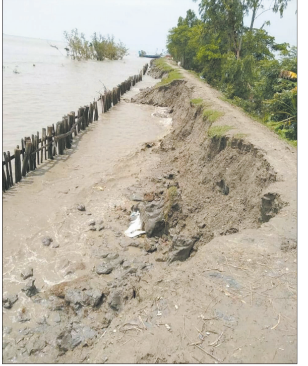
বর্ষা কোটালে জল বাড়ছে নদী সলংগ এলাকায়। দক্ষিণ ২৪ পরগনার ডিএস-২ গ্রামপঞ্চায়েতের স্মৃতিনগর ফেরিঘাট এলাকায় নদীবাঁধে ধস। প্ধুপ্লাবিত হওয়ার আশঙ্কায় দিন কাটাচ্ছে বেশ কিছু পরিবার।
